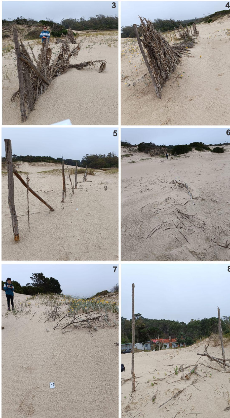
Figura 24. barreras captoras. 3: barrera 3 en malas condiciones y con acumulación de arena, 4: barrera 4 en malas condiciones y con ripples paralelos a ella, 5: barrera en donde solo permanecen los soportes, 6: barrera 6 tapada de arena y con vegetación, barrera 7: barrera 7 también cubierta de arena, barrera 8: Soportes de barrera 8.
