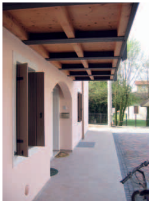
Particolare di una casa in costruzione
