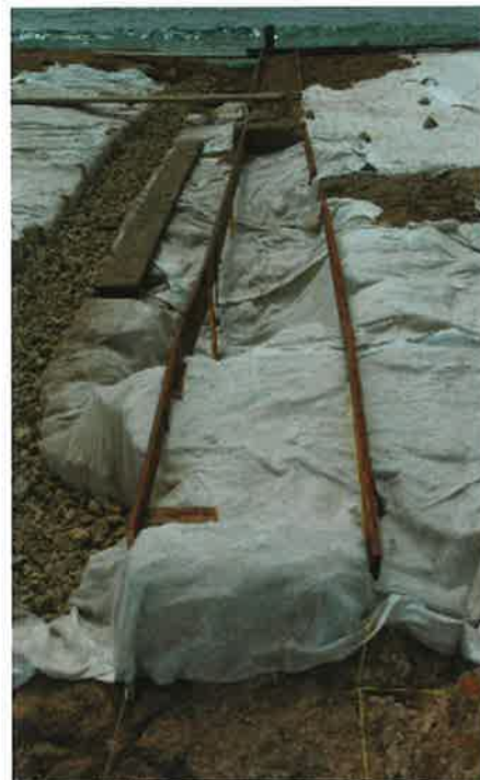
I lavori al foro: al centro tessuto non tessuto e assi di legno per il colonnato del portico ovest, a sinistra ghiaio drenante nella canaletta.
