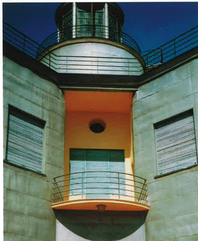
Villa Girasole, rivestimento facciate con lastre di alluminio.
