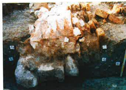
8. Roncade (TV), Tenuta di Ca' Tron. Saggio 7. La sezione del lacerto di muro della testata settentrionale del ponte lungo il percorso «interno» della via Annia, crollato nell'alveo. (Foto dell'autore)
