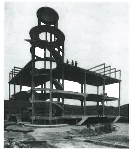
Villa Girasole, disegno prospettico (1929) e struttura in cemento armato (1930).
