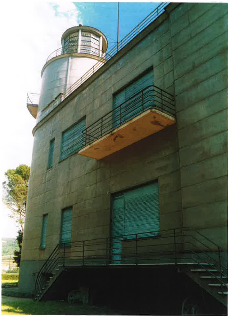
Villa Girasole, prospetto con i carrelli motore. Sopra, pianta della parte girevole.
