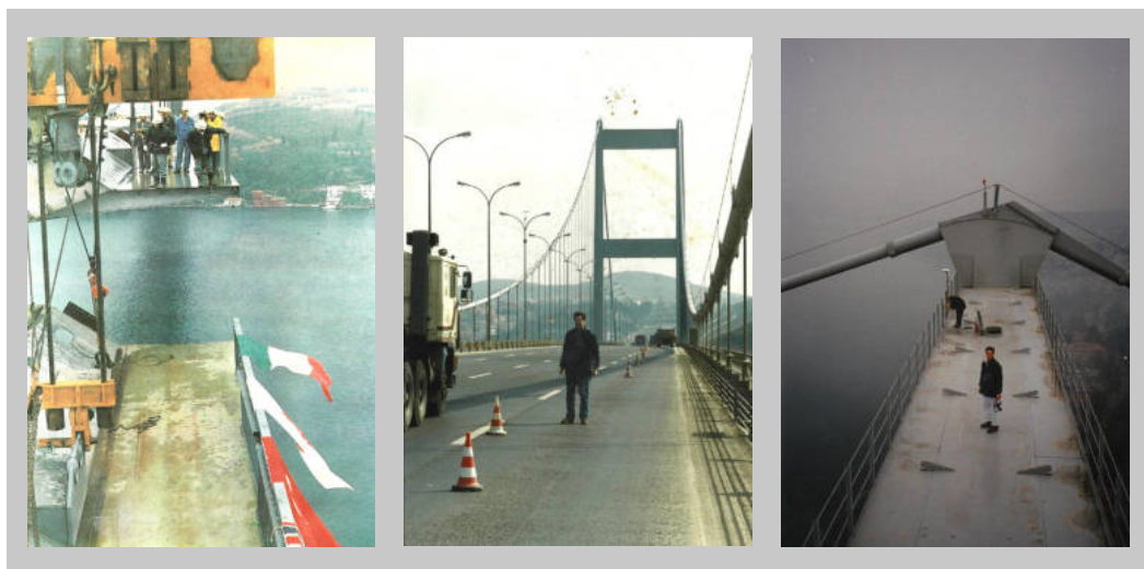
Fig. 10 - Secondo ponte sul Bosforo: sollevamento concio di chiusura e foto di cantiere
