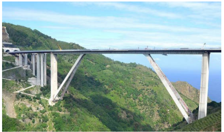
Fig. 2 - Viadotto Sfalassà, Silvano Zorzi
