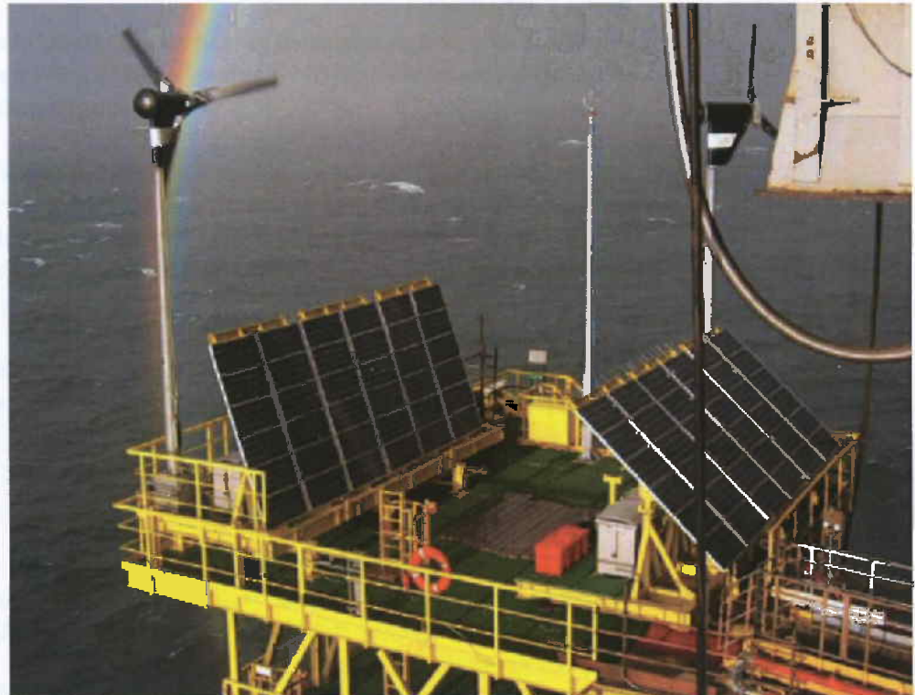
Figuur 4.4 Foto van de bovenzijde van het in 2005 geplaatste K-17-Da-1 platform (vergelijkbaar met het te realiseren satellietplatform M7-A) met hierop windmolens en zonnepanelen.
