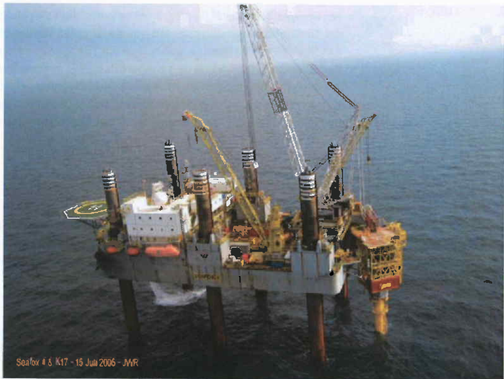
Figuur 4.5 Plaatsing bovenbouw platform K17-FA-1 (rechts in de takels hangend) met behulp van een hefbaar werkeiland.
