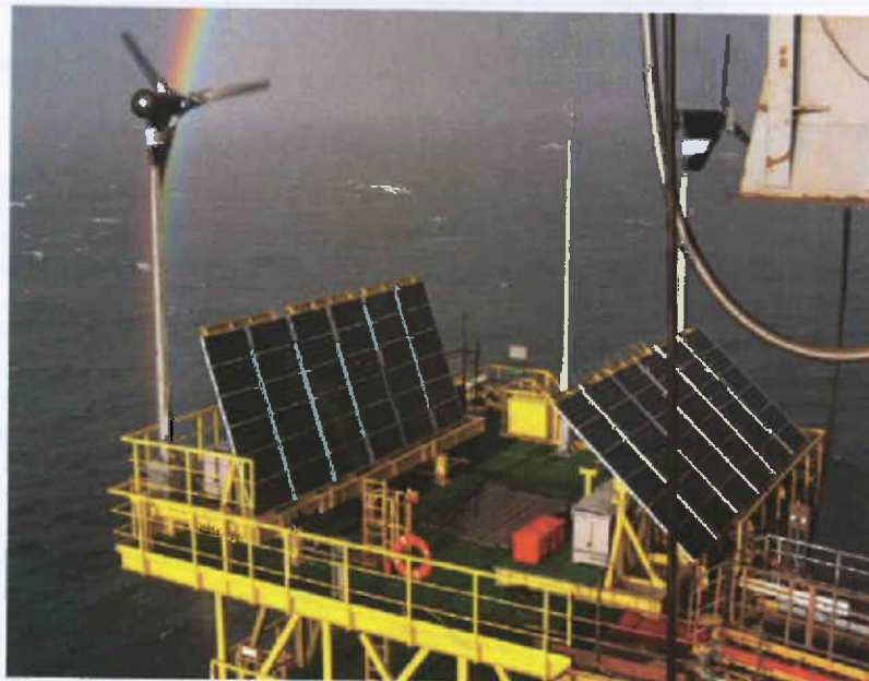
Figuur S4 Foto van de bovenzijde van het in 2005 geplaatste K17-FA-1 platform (vergelijkbaar met het te realiseren satellietplatform M7-A met hierop windmolens en zonnepanelen).
