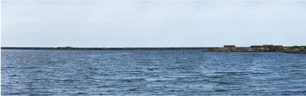
Figuur Huidige situatie gezien vanaf de Kabellaarsbank
