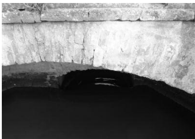
Figura 13. La chiavica posta all'estrema destra da cui scaturisce il Bocchello di Chieve.
