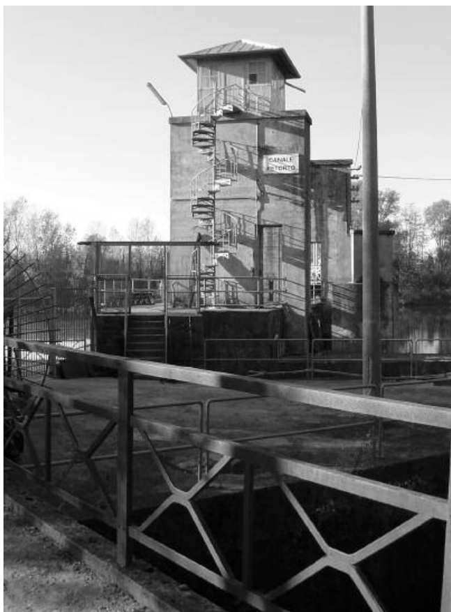
Figura 1. La Torre contenente i meccanismi di controllo della diga del Retorto alla presa dell'Adda.
