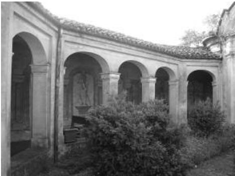
Figura 25. Il porticato Ovest.
