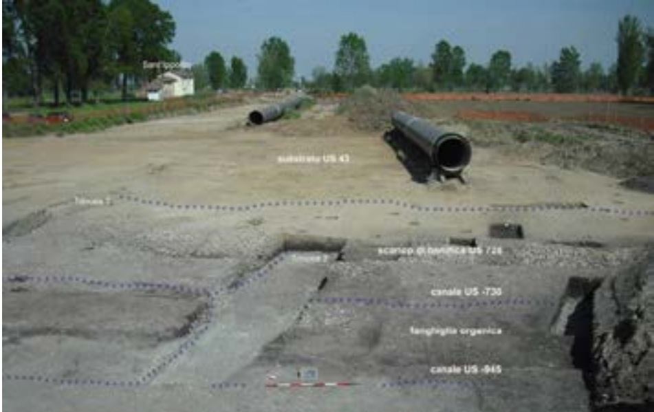
16. Panoramica dell'area 1 e 3
