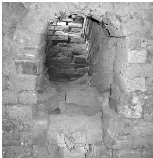
Aperture per carico combustibile
