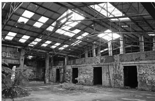
C/D - Interno fornace Fusi
