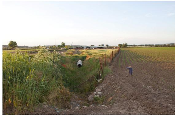
Infraestructuras hidráulicas en el entorno; en la imagen inferior derecha aparece el colector que drena los campos aledaños y que desagua en la gravera
