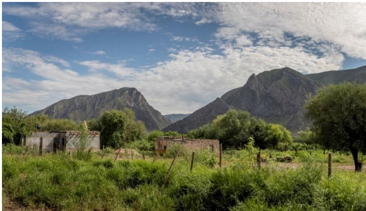
Figura 65. Vista panorámica de la entrada a la Presa Francisco Zarco.
