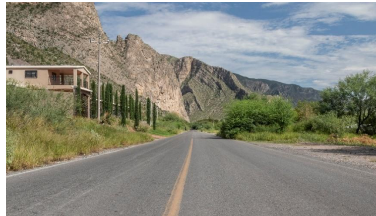
Figura 66. Vista panorámica camino de entrada a la presa Francisco Zarco por el poblado de Graseros.
