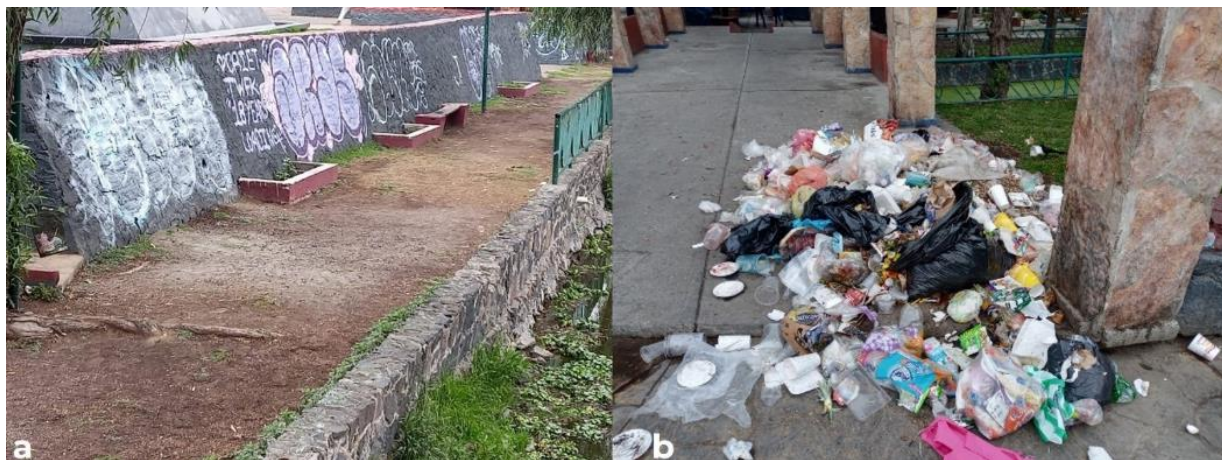
Figura 100. Impactos negativos en el embarcadero de los Reyes Aztecas derivado de la falta de vigilancia como los grafitis en la infraestructura (a) y un inadecuado manejo de la basura y residuos producto de la visitación turística (b).
