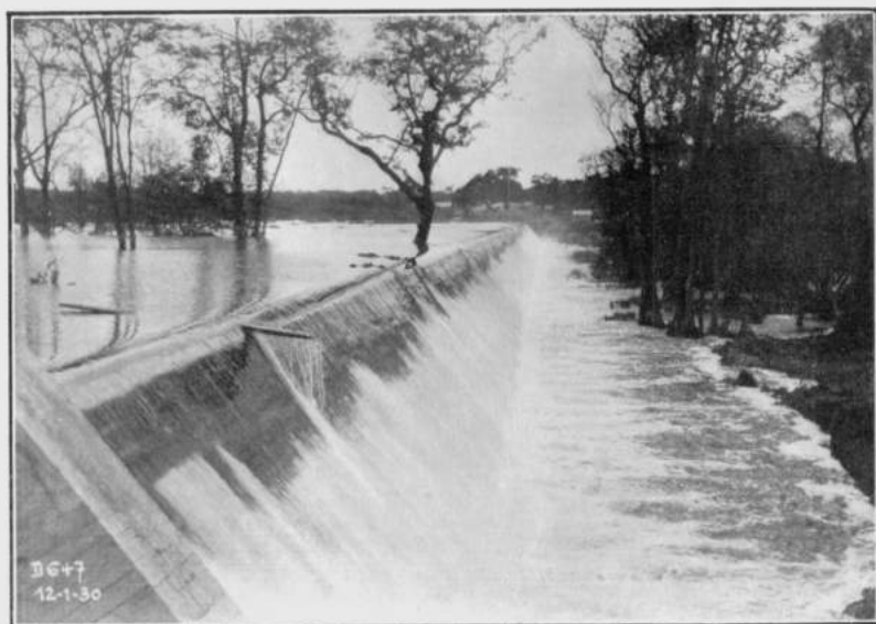
FIG. 3. — Vue d'ensemble du barrage.
