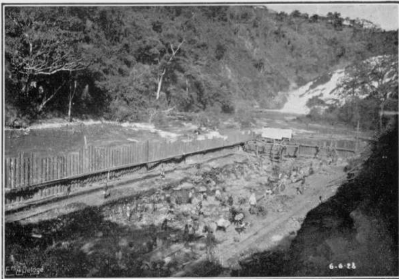
FIG. 15. — Centrale principale. Vue d'ensemble des excavations et du batardeau.
