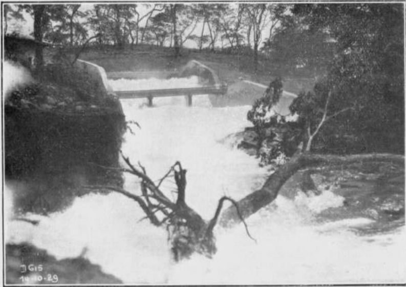
FIG. 14. — Canal de décharge après dérivation de la Lufira.
