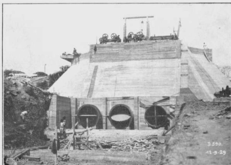
FIG. 6. — Chambre de mise en charge. — Mur aval.
