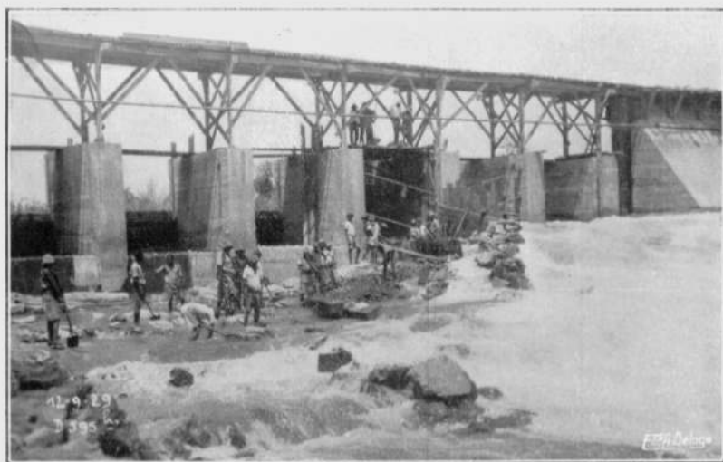
FIG. 13. — Travaux préparatoires pour fermeture et bétonnage de la passe du barrage.
