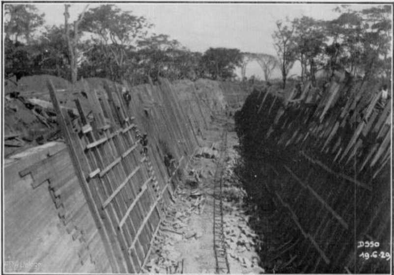
FIG. 5. — Coffrages pour revêtement du canal de dérivation.
