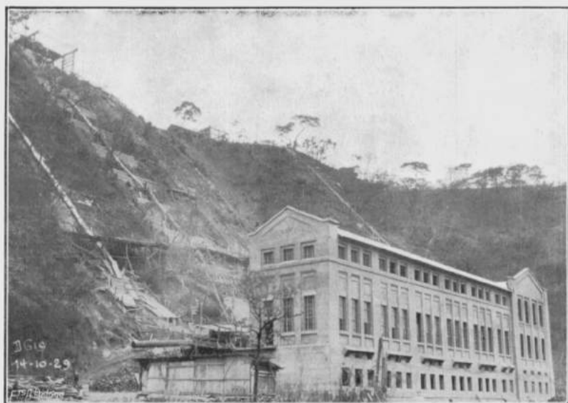
FIG. 9. — Façade aval de la centrale.
