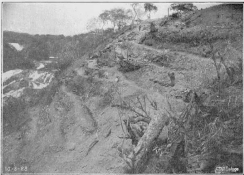
FIG. 16. — Déblais pour le plan incliné et les conduites forcées.
