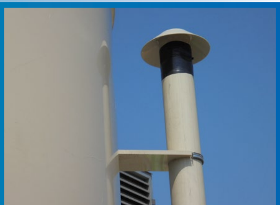
fig. 12 - Sistema di sicurezza per sovrappressione
