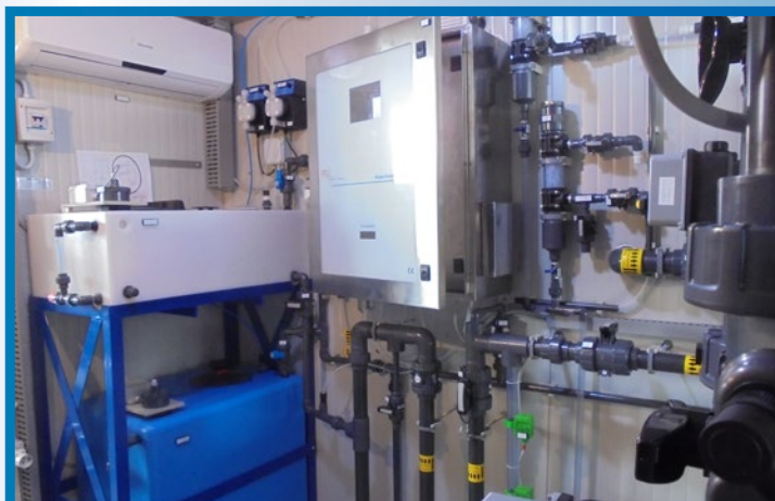
fig. 5 - Dettaglio del serbatoio nutrienti, batteri e analizzatore BioGas
