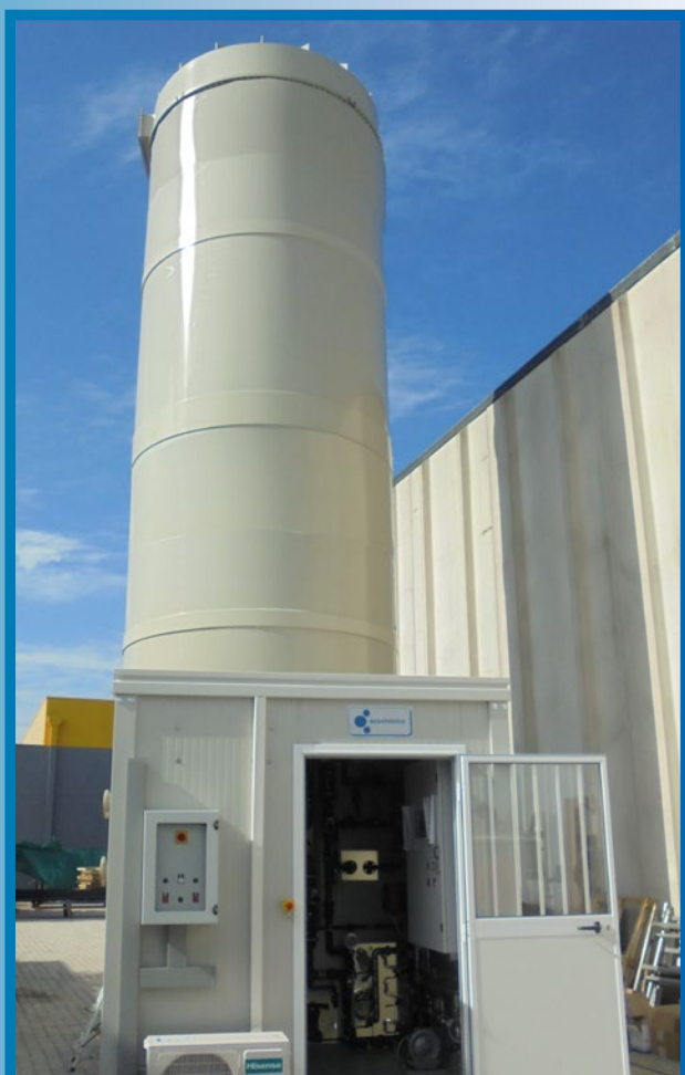
fig. 2 - ECOCHIMICA BIO-DESOLF® con Torre e Stazione di Controllo
