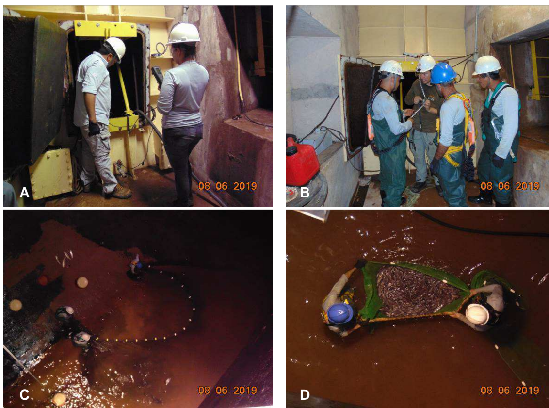
Figura 2. Procedimentos para entrada na sucção da UG01, na UHE Colíder, junho de 2019. A: Registro dos dados abióticos da água; B: Instruções de segurança para entrada da equipe; C: Resgate com utilização de arrasto e D: Resgate com utilização de picaré.
