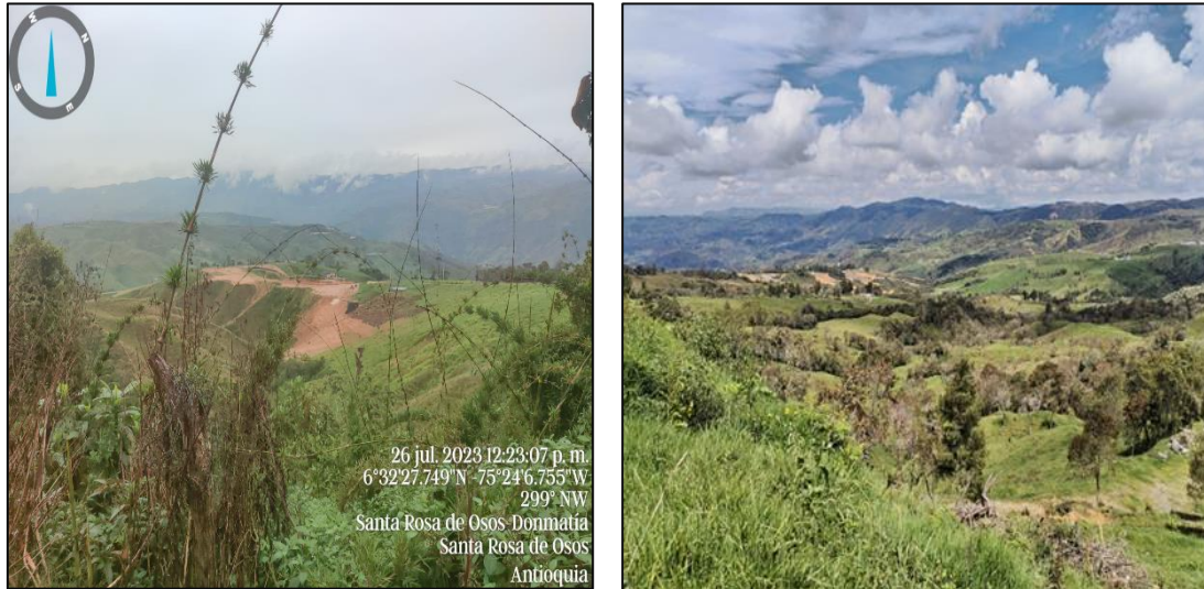
Fotografías 1, 2, 3 y 4. Procesos erosivos en laderas de lomos punteados en las veredas Río Grande, cerca de la quebrada La Gómez y en San Isidro Parte Baja, ceca del Río Grande; desarrollo de actividades agropecuarias y apertura de vías en la vereda Río Grande, municipio de Santa Rosa de Osos. Fuente: Corantioquia 2023.
