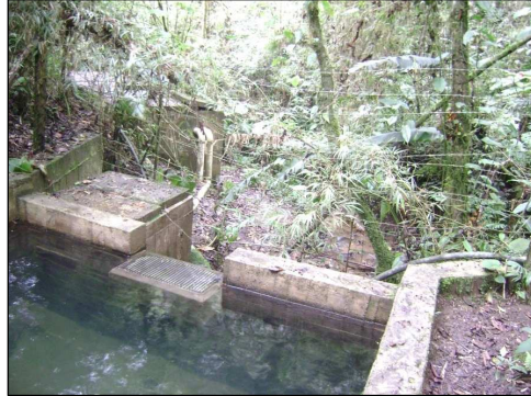
Foto 35. Obras de Captación Acueducto Agua plan.
