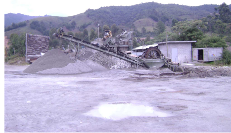
Foto 67. Practica Minera a gran escala en la Cuenca realizada por SERVIMINAS
