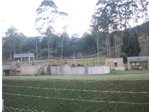
Foto 43. Planta de tratamiento de aguas residuales de Empresas Publicas de Medellín
