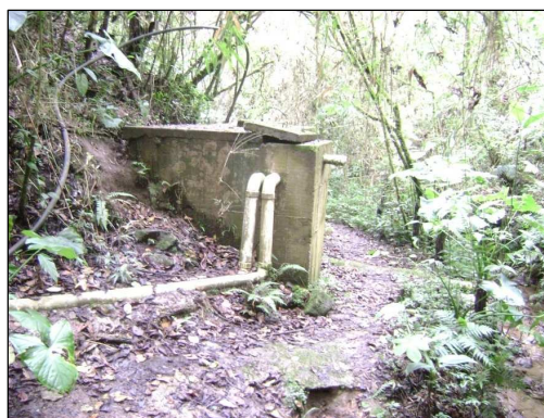
Foto 36. Desarenador Acueducto AGUAPLAN
