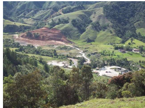
Foto 69. Panorámica de la Cuenca La Agudelo en la parte media, intervenida por SERVIMINAS
