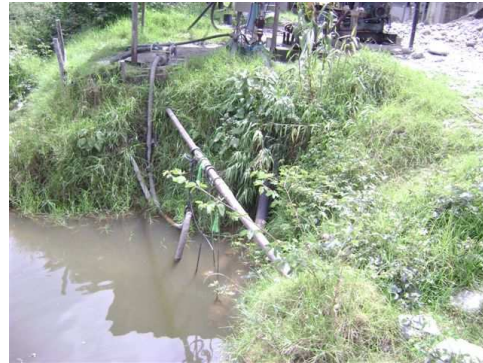
Foto 46. Captación de agua de la quebrada La Agudelo por la Empresa SERVIMINAS
