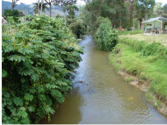
Foto 7. Tramo recto de la parte baja de la quebrada en las inmediaciones del puente via Mirador del Retiro.
