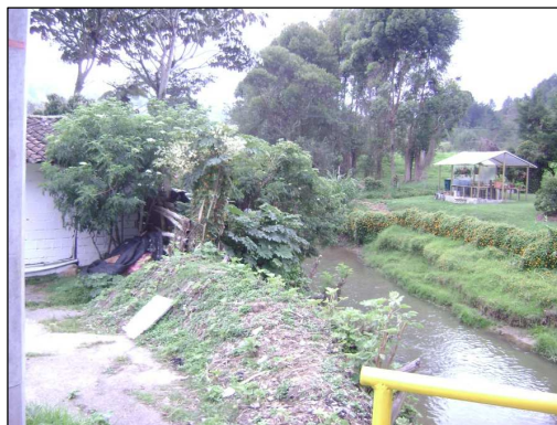
Foto 71. Vivienda a 3 metros de la quebrada la Agudelo (barrio El Pino)
