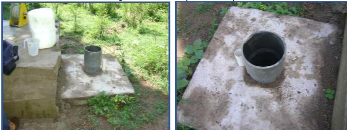
Figura 4-16. Boca del pozo El Trabajo
