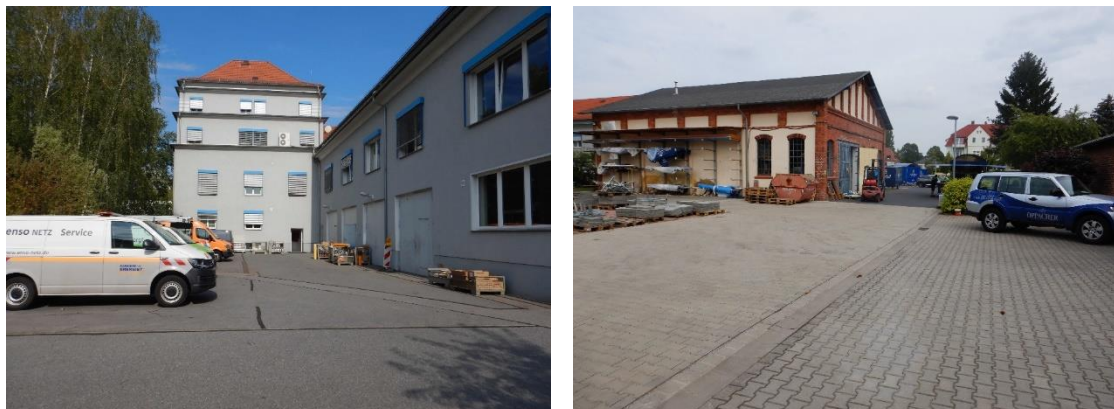
Foto 4: Gewerbefläche Fabrikstraße 11 (links), Gewerbefläche Fabrikstraße 9 (rechts)
