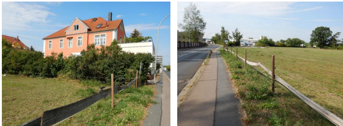
Foto 5: Wohnbebauung an der Fabrikstraße 7 und 9 (links), Intensivgrünland Ecke Fabrikstraße/Cliebener Straße mit Blick auf die Gewerbenutzung an der Cliebener Straße (rechts)
