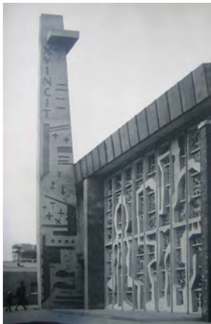
AFBEELDING 4.41 MAX RENEMAN EN COEN BEKINK (ARCHITECT), PHOENIX, 1960, CHRISTUS KONINGKERK UTRECHT, GLAS- IN-BETON.
