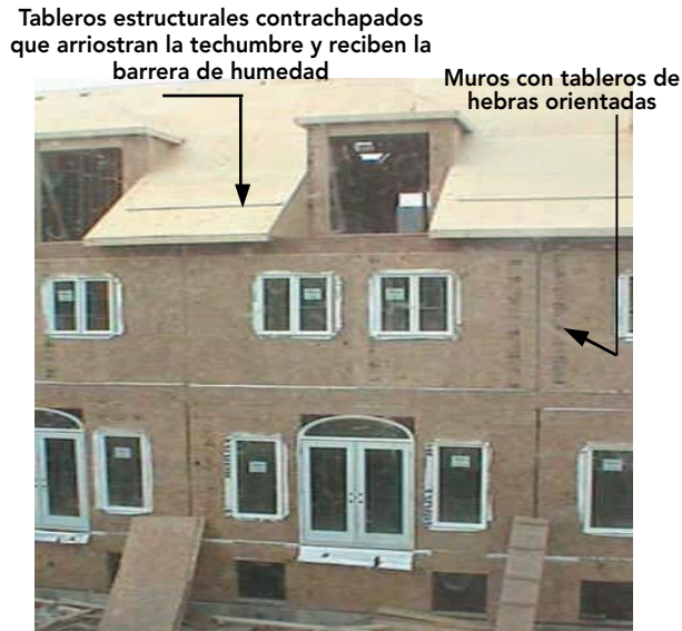
Figura 17-17 A: Vivienda con tableros contrachapados fenólicos en la techumbre y de hebras orientadas en muros.
