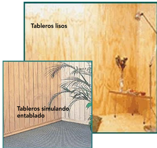
Figura 19 - 23: Revestimiento con tableros contrachapados.
