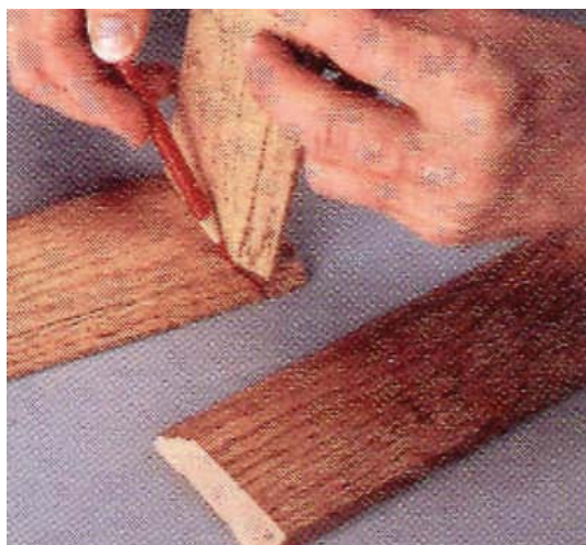
Figura 21-11: Utilizando un trozo de la moldura a la que llegará la moldura que lleva el corte doble, se marca sobre ésta la figura del corte requerido.
