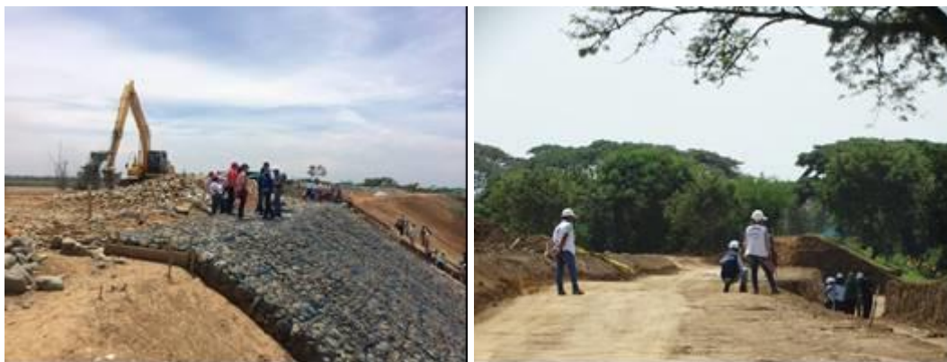
Imágenes 17 y 18. Obras de reforzamiento del Jarillón del río Cauca (Fuente: El País , 2017 y CVC, 2018)
