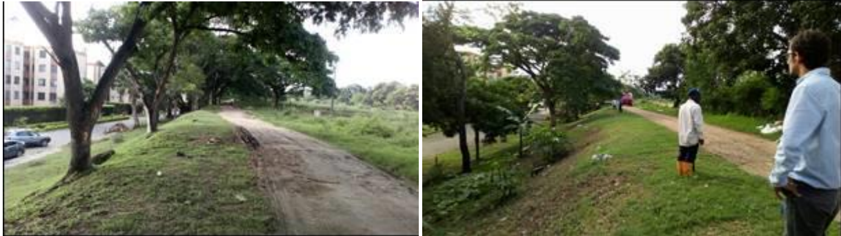
Imagen 7 y 8. Corona del dique y árboles aislados en el talud de la cara seca.
