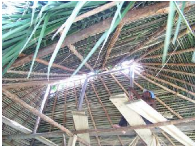
Foto 57. Techo en hoja de Corozo.
