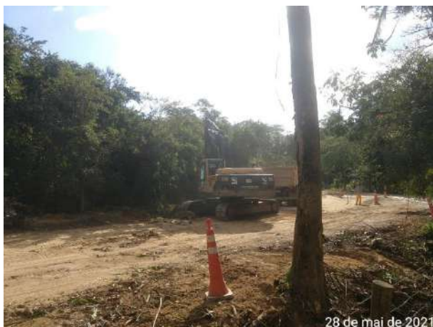
Foto 1 – Remoção dos resíduos florestais oriundos da supressão do indivíduo arbóreo isolado em risco de queda. (Registro fotográfico 28/05/2021).
