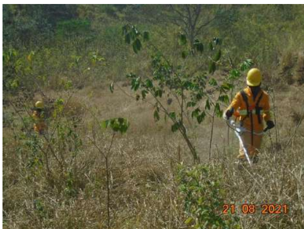
Foto 37 – Atividade de roçada semimecanizada.
