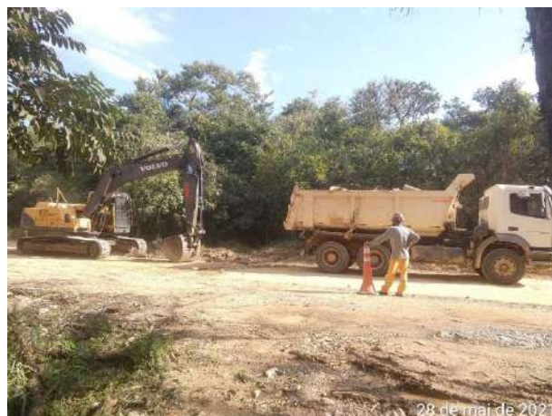
Foto 2 – Remoção dos resíduos florestais oriundos da supressão do indivíduo arbóreo isolado em risco de queda. (Registro fotográfico 28/05/2021).
