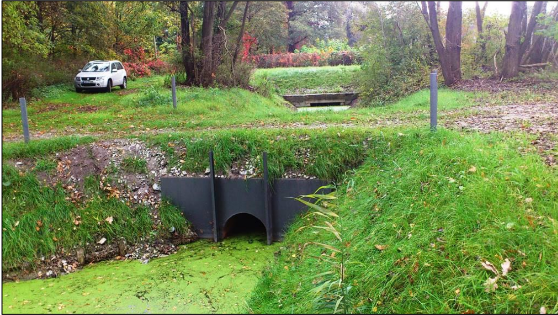
Abb. 8: Mögliche Ausführungsvariante für ein regulierbares Staubauwerk – Stahlrohr mit angeschweißtem Staurahmen (Foto: WBV „Dahme-Notte“)
