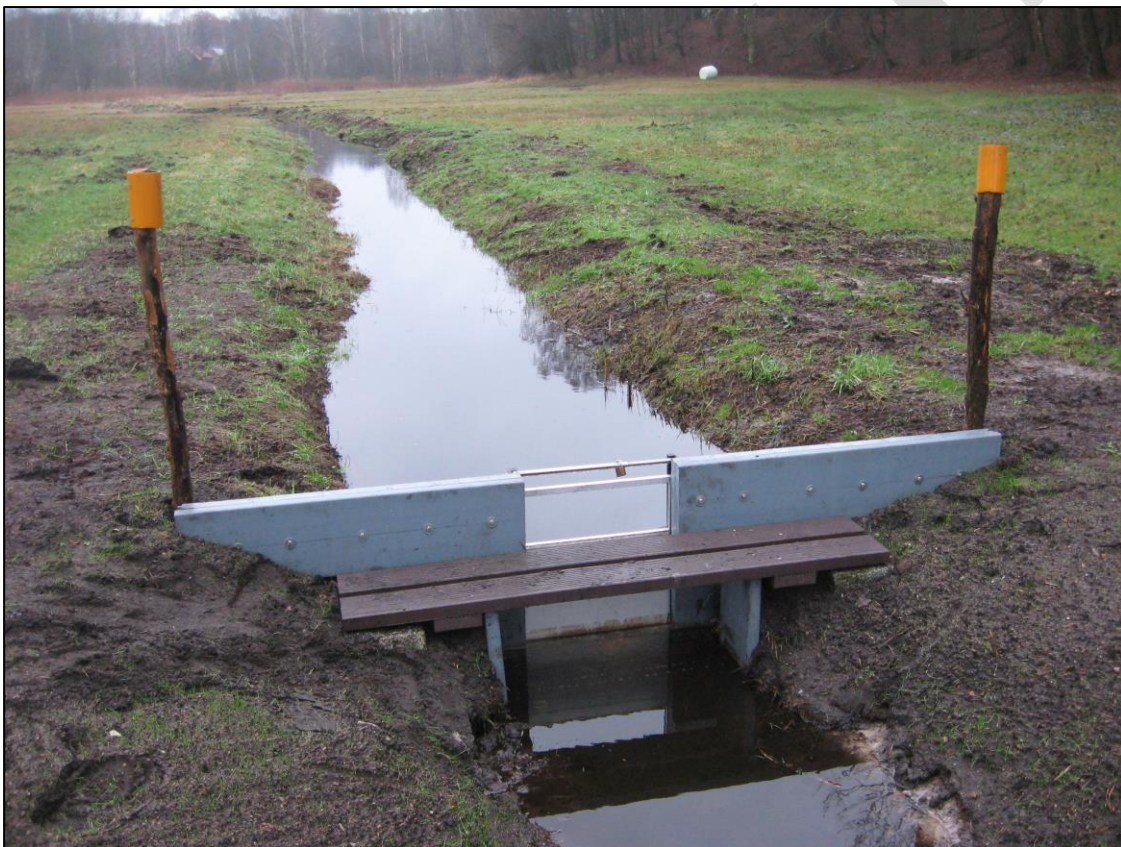
Abb. 9: Moorgrabenstauanlage „Typ Beeskow“ (Foto: WBV Mittlere Spree)
