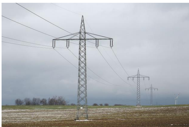
Abbildung 2.2: Typische Bahnstromleitung mit zwei Stromkreisen (links), Bildquelle: Wikipedia Commons
