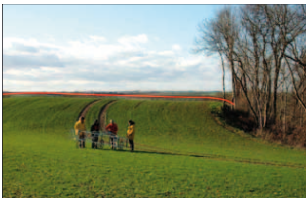
Abb. 4: Der Höhenverlust auf der Hauptwallkrone beträgt seit 1950 ca. 0,6 m.
