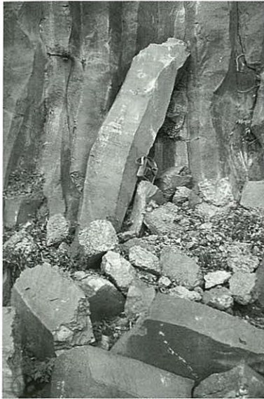
Columnes prismàtiques alterades a Castellfolit de la Roca.
