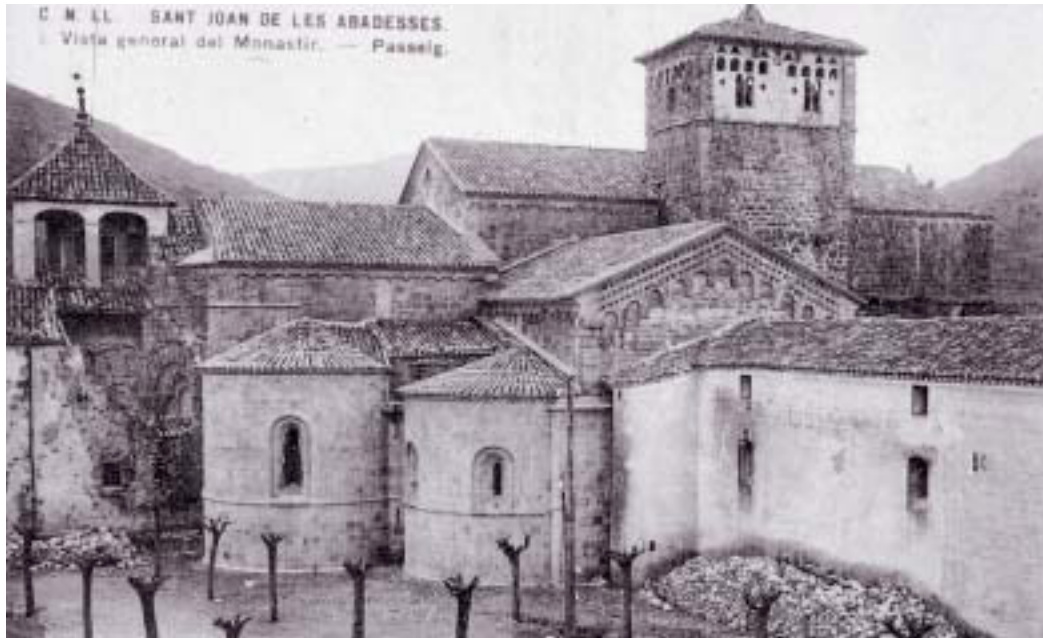
▲ El monestir de Sant Joan durant unes obres de restauració
