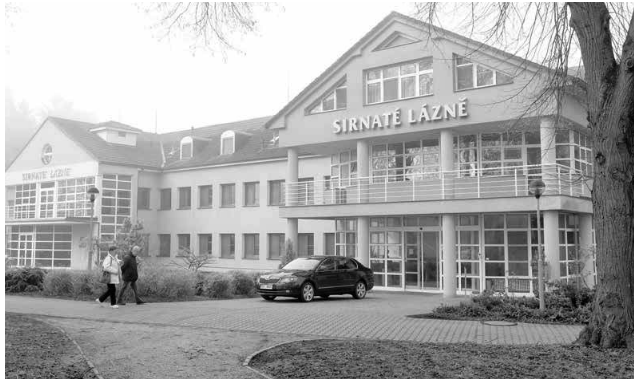
Centrální budova lázní leží v takzvaném vnitřním ochranném pásmu. FOTO: SAL
