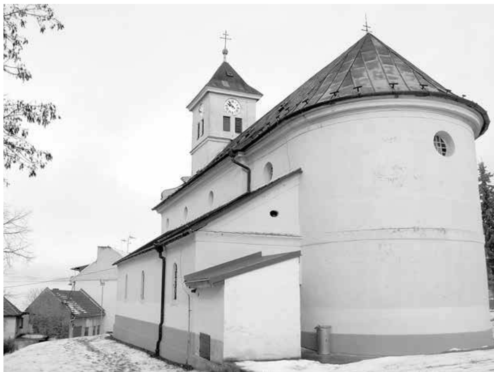
Kostel v Korytné prochází postupnou obnovou, ještě chybí nové nátěry. FOTO: ARA
