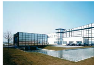
ODS Optical Service GmbH 264 MOBOTIX Kameras, Deutschland
