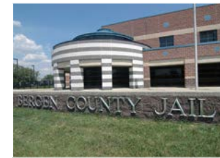
Bergen County Jail 820 MOBOTIX Kameras, USA
