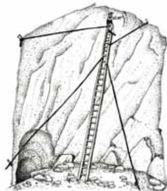
Dyn diogelwch yn clirio'r creigiau rhydd Dangerman clearing loose rock
