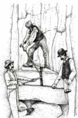
Torri'r slabiau / Splitting slabs
