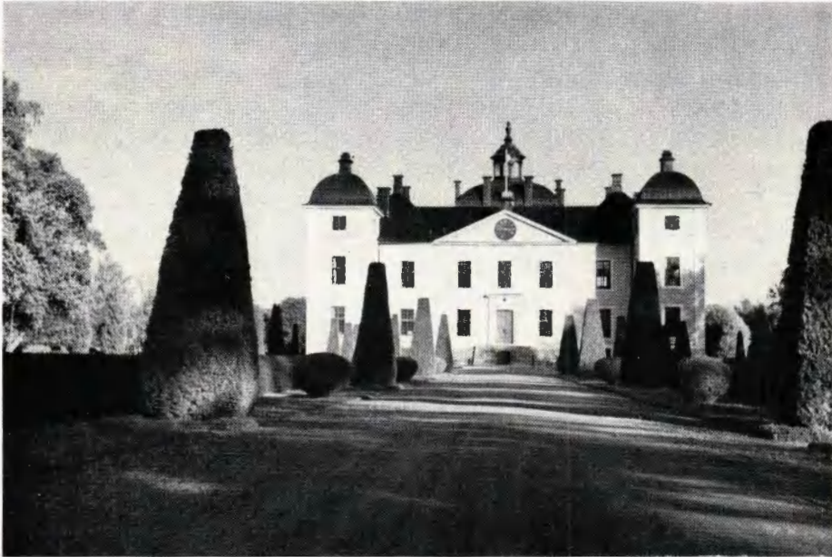
Fig. 4. Här råder fullständig harmoni mellan byggnadens och trädgårdens arkitektur, och man anar inte, att trädgårdsbarocken utförts under 1930-talet och på platsen för den ursprungliga borggården. Strömsholms slott. — Foto S. I. Andersson. — Complete harmony between a 17th-century castle and a formal garden, laid about 1930 on the site of the old court-yard. Strömsholm, province of Västmanland.
