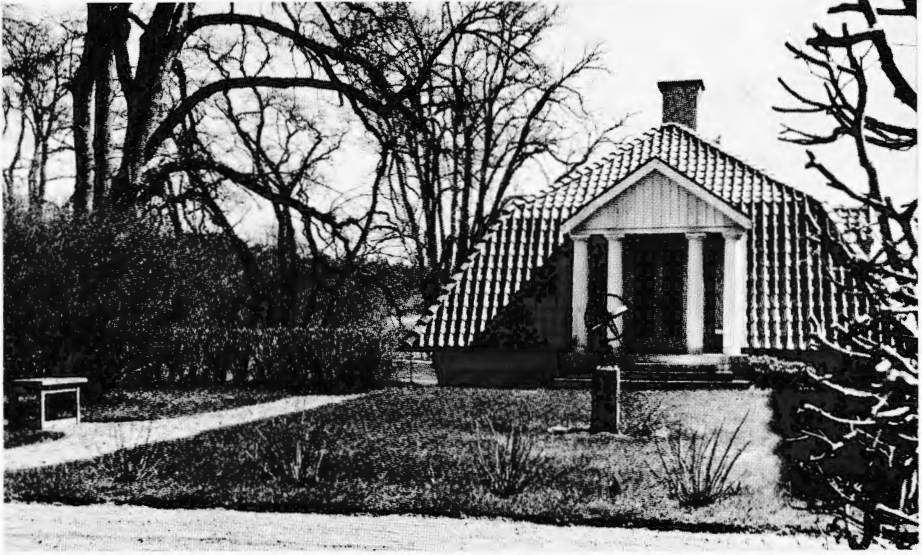
Fig. 14. Stjärnorps. Norra bostadsflygelns gavel mot parken. Tempelfrontonen och den innanför liggande trädgårdssalongen ordnad omkr. 1914. Platsen framför då arrangerad som rosenträdgård. — Foto M. Johnson 1965. — Stjärnorps. The gable of the northern wing towards the park.
