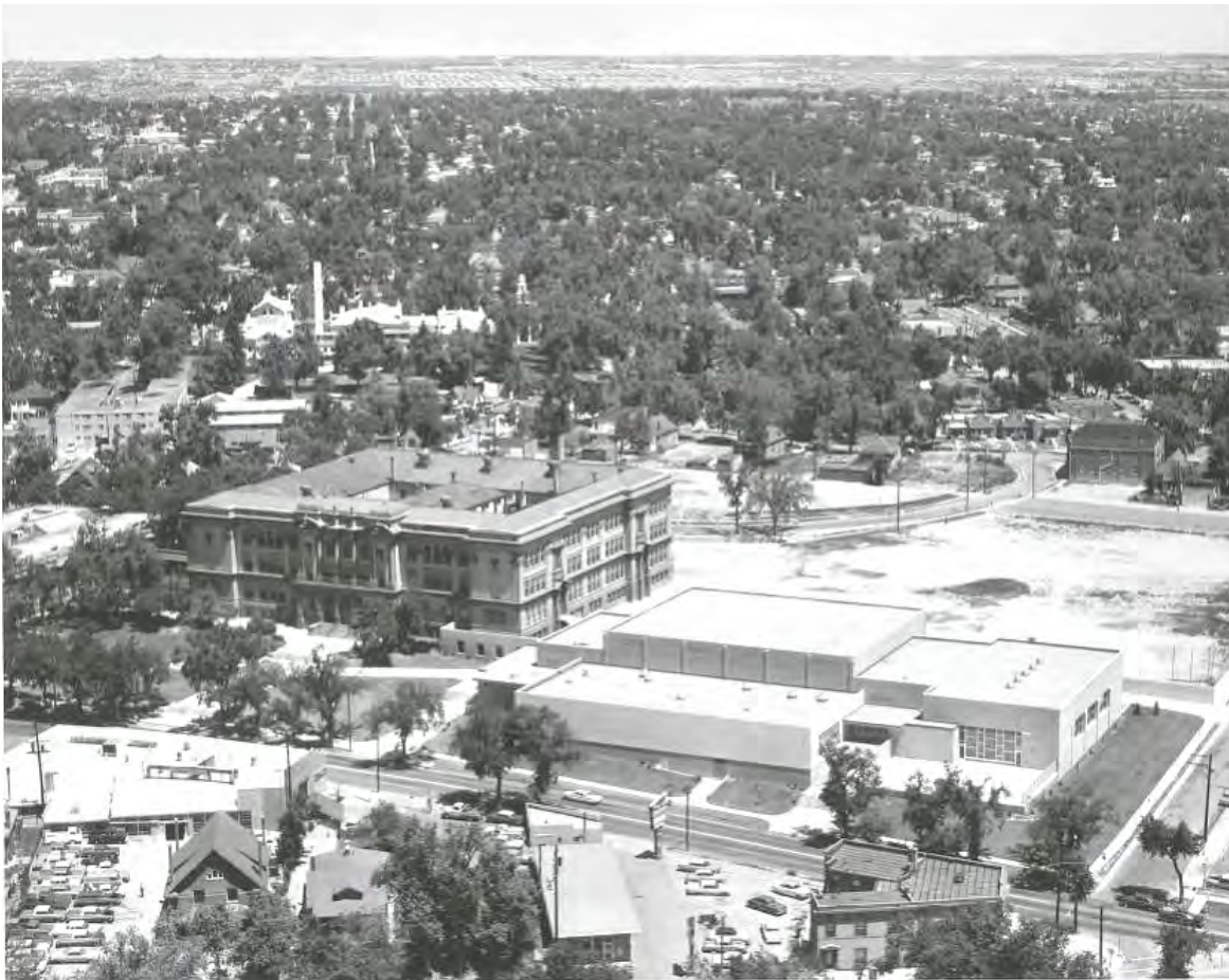
Figura 44. Fotografía aérea del campus de la Secundaria North, 1961, vista hacia el norte. 255
