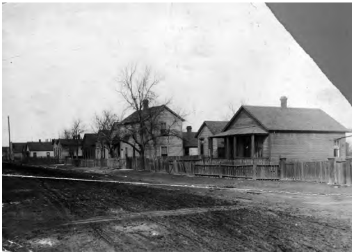
Figura 14. Vista de las casas sobre Fox Street, entre las vías ferroviarias y Globeville, cerca de “Los Bajíos” del Río Platte Sur. 55
