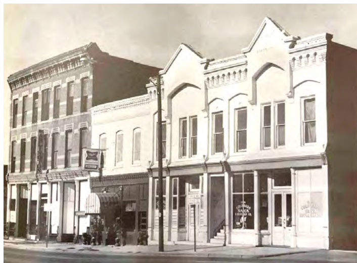
Figura 40. Comercios sobre Larimer Street en Auraria entre 13th Street y Speer Boulevard, circa 1970. Estas estructuras se demolieron por completo durante la construcción del Campus de Auraria. 240
