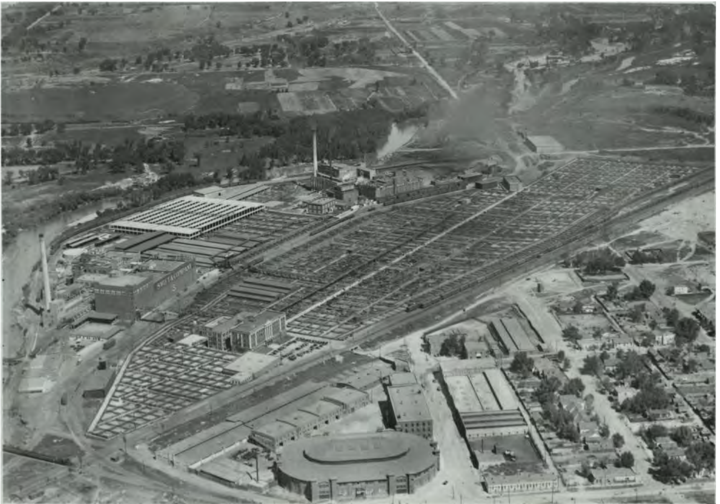
Figura 17. Los Corrales de Denver Union y los frigoríficos del Eastside eran fuentes de empleo para muchos latinos. Ubicados al este del Río Platte Sur, las plantas de los frigoríficos, de fundición metalúrgica y de otras industrias, estaban cerca de los vecindarios de Globeville, Elyria y Swansea, donde vivían las clases trabajadoras. Las cuadras residenciales de Elyria pueden verse a la derecha de la fotografía. 60
