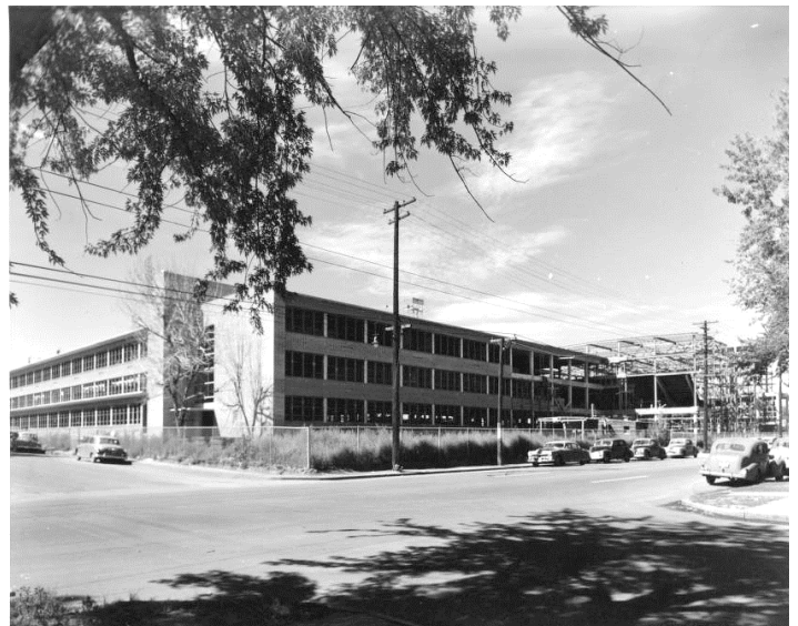
Figura 46. Construcción de la Nueva Escuela Secundaria Manual, 1952. 274
