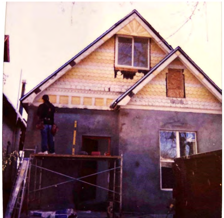
Figura 65. Vivienda de Sánchez en 3340 Lafayette Street, lugar de las primeras transmisiones de la KSFCs. 368
