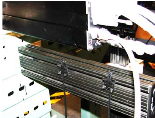
FÜGEN SIE DIE KABELBINDERSCHELLEN IN DIE LEISTE EIN UND DREHEN SIE UM 90°. FÜGEN SIE DIE KABELBINDER IN DIE HALTERUNG EIN
