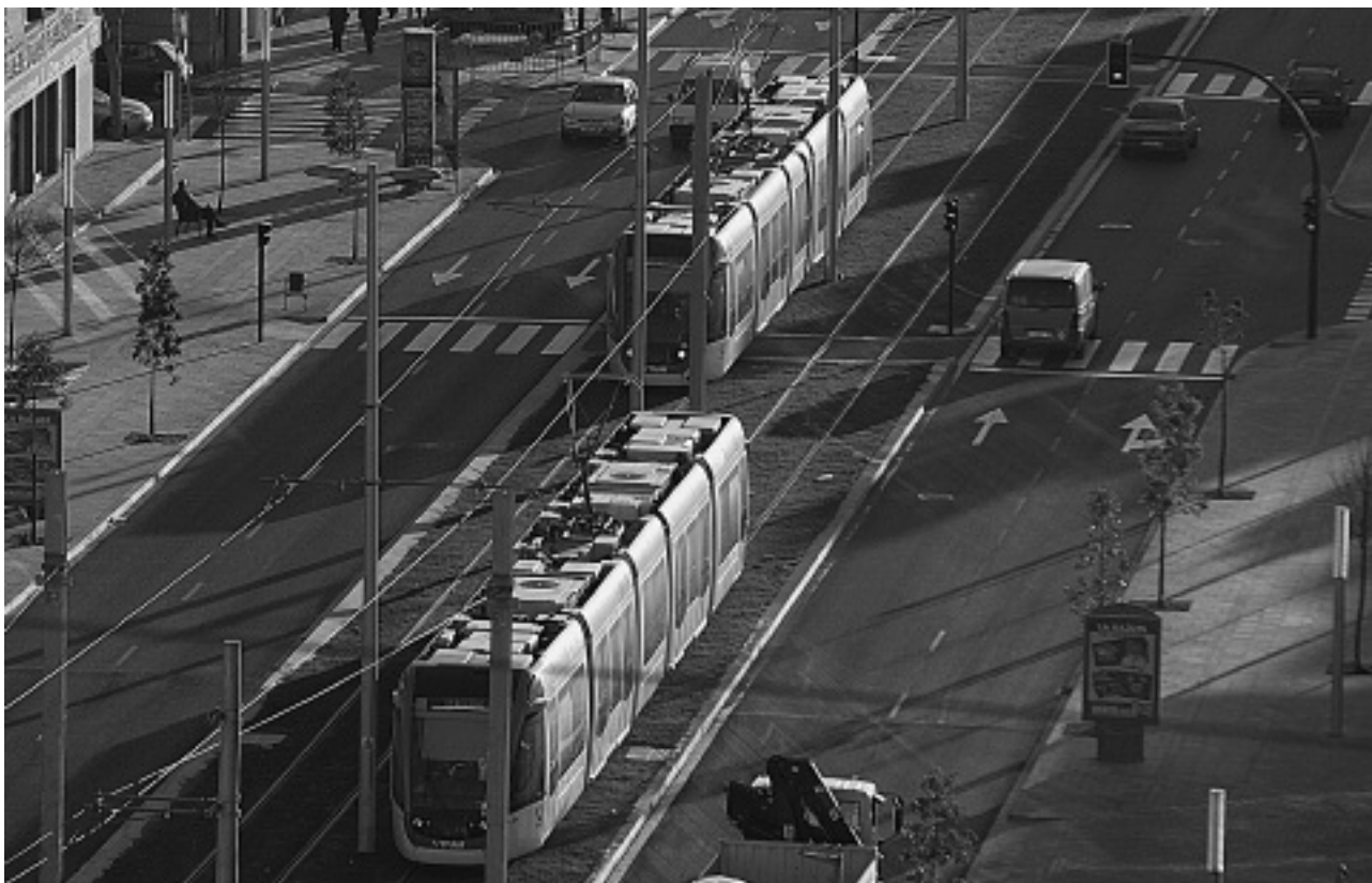
Vista aèria d'un tram de la xarxa tramviària Diagonal-Baix Llobregat.
