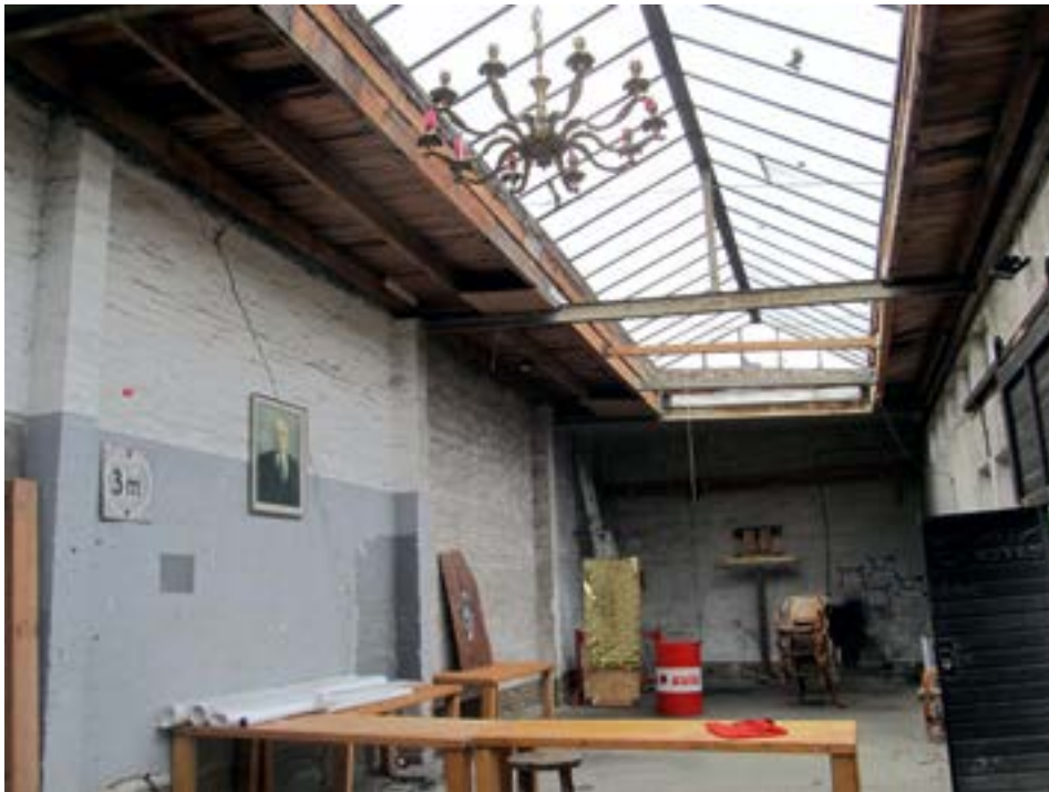
Blick in die ehemalige Fahrzeughalle
