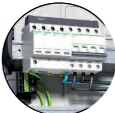
Überspannungsableiter iPRD 4P + iC60N 4P
