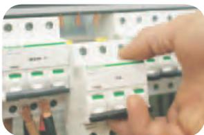
Egal ob die Kammschiene oben oder unten montiert ist – dank dem neuen Befestigungselement können Sie jederzeit Einzelgeräte aus dem querverschienten Geräteverbund entnehmen und tauschen.
