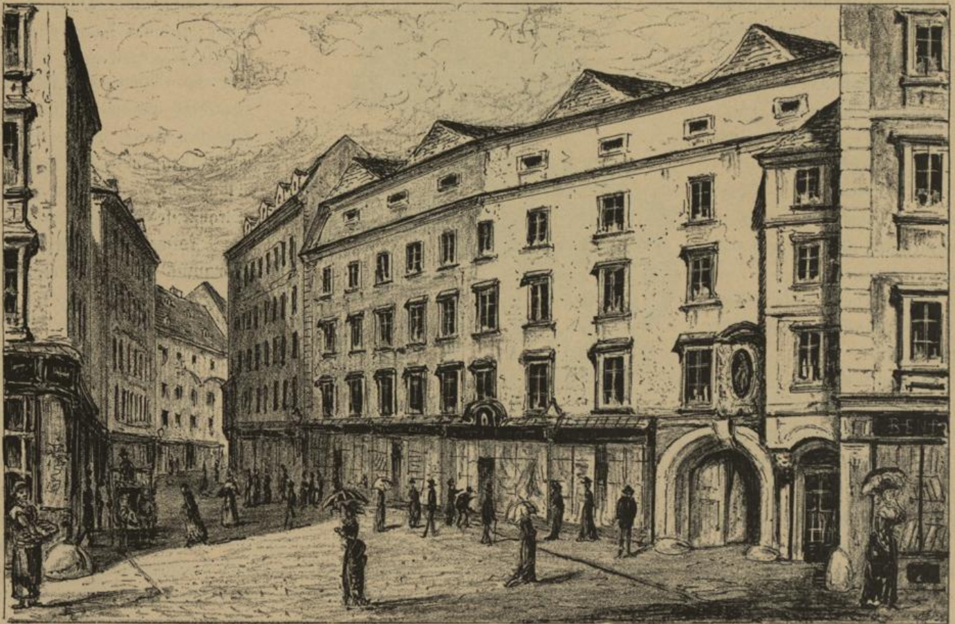
Die Außenseite des Margarethenhofes am Bauernmarkt vor der Demolition. Originalaufnahme.
