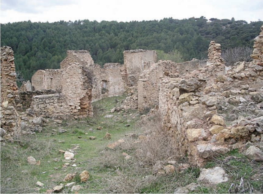
Foto 3.—Aldea abandonada de Los Goldines en la Sierra de Segura.
