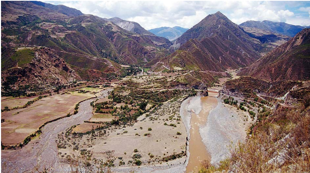
Tal des Rio Apurimac südlich Paruro mit der neuen Brücke
