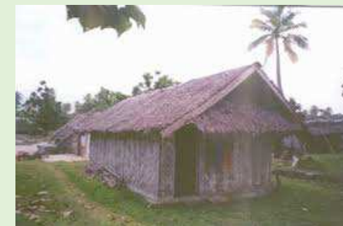
Case en bambou avec toit en feuille de palme au Vanuatu. Source image : http://www.sinerj.org/~jbdenis/frederic/santo/portolry.html
