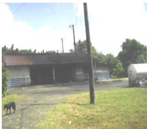
Centrale Thermo-électrique JIRAMA, Fénérive-Est
