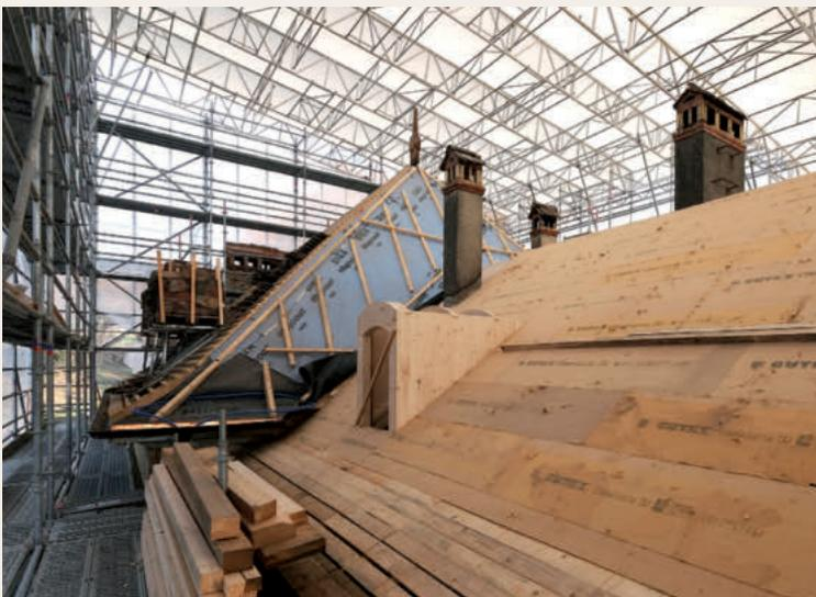
*Dämmung der Seitenflügel (zwischen den Sparren, mit Unterdachplatte) und der Pavillons (auf den Sparren). Der Giebel, der links zu sehen ist, nimmt den zusätzlichen Dachaufbau auf.*
