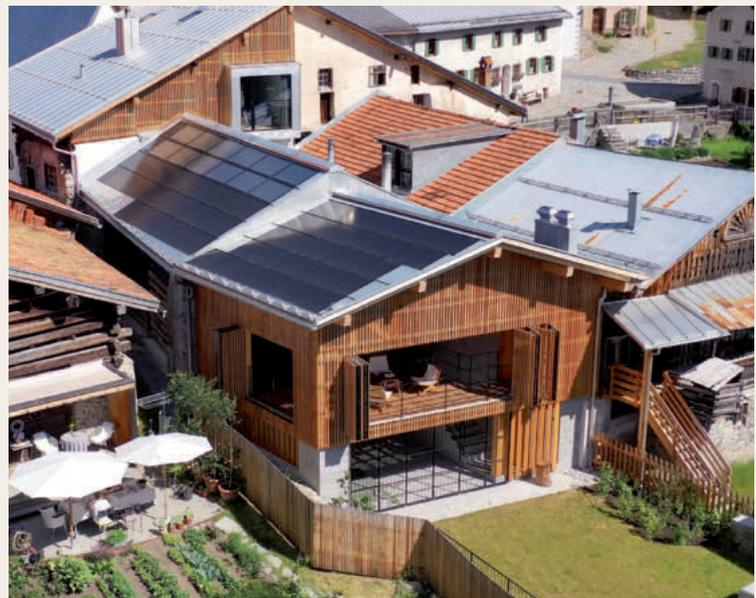
*Das «Solarkraftwerk» des Hauses San Niclo 9, das den gesamten Energiebedarf des renovierten Gebäudes abdeckt.*
