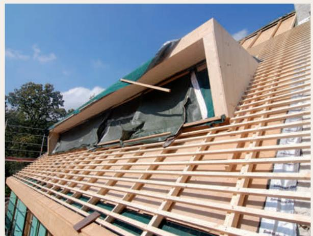
*Die Dachdämmung, bestehend aus Zellulosewatte und einem Unterdach aus Holzfasern.*
