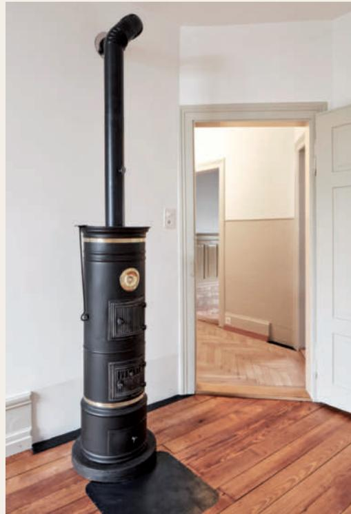
*Einer der originalen gusseisernen Öfen. Im Gegensatz zu Kachelöfen sind diese Öfen, die keine Speichermasse aufweisen, sehr reaktionsschnell und die erzeugte Wärme verteilt sich rasch. Sie wird dann in den Mauern und Wänden gespeichert, die als Puffer dienen und für gleichbleibende Temperaturen und ein angenehmes Raumklima sorgen.*
