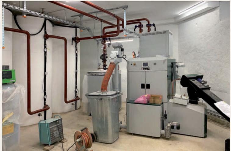
*Die neue Holzsnitzel-Heizung. Auffallend ist die geringe Grösse dieser Anlage, mit der die etwa 7000 m<sup>2</sup> grosse Geschossfläche des Schlosses beheizt wird. Rechts die Förderschnecke, links die Speicher zur gleichmässigen Wärmeverteilung.*
