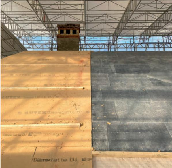
*Dämmung des Hauptkörpers. Links: Herkömmliche Unterdachplatten, wie sie auch in den Seitenflügeln verwendet werden. Rechts: Hochleistungsfähige Aerogel-Platten.*
