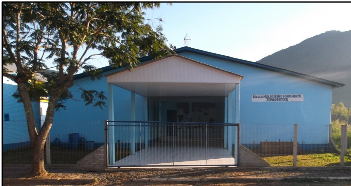
Imagem 03: Escola Municipal de Ensino Fundamental Tiradentes. Fevereiro de 2015.
