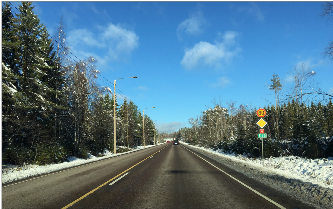
Kuva 2-14. Valtatie 4 on Joutsan kuntakeskuksen kohdalla kaksikaistainen tie ja nopeusrajoitus on 80 km/h. Keskustan pohjoispuolella valtatiellä ei ole yhtenäistä rinnakkaistieverkkoa, mikä vaikeuttaa valtatieen varalaskupaikan harjoituskäyttöä sekä heikentää jalankulun ja pyöräilyn olosuhteita.
