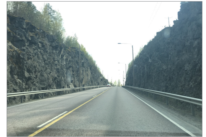
Kuva 2-8. Joutsansalmen eteläpuolella valtatie 4 on enimmillään noin 12 metrin kallioleikkauksessa.
