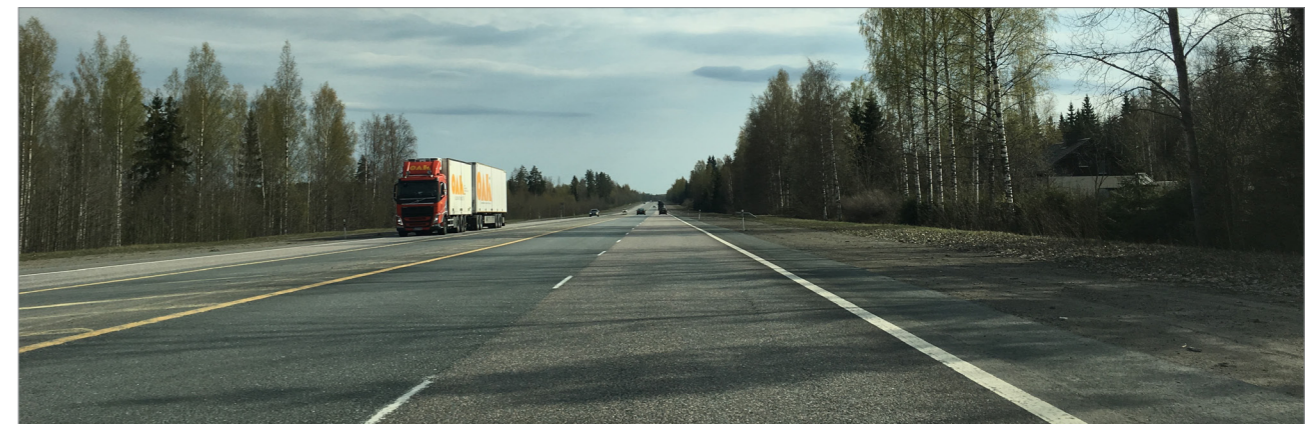
Kuva 2-6. Joutsan kuntakeskuksen pohjoispuolella sijaitseva valtatie 4 varalaskupaikka.
