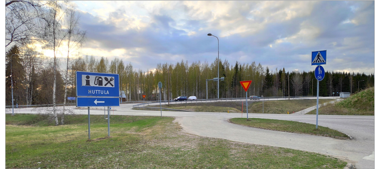
Kuva 5-1. Valtatie 4 ja Yhdystien (mt 16646) liittymän eli ns. Huttulan liittymän kohdalla uusi eritasoliittymä aiheuttaa suuria muutoksia maisemaan ja kulkureitteihin.
