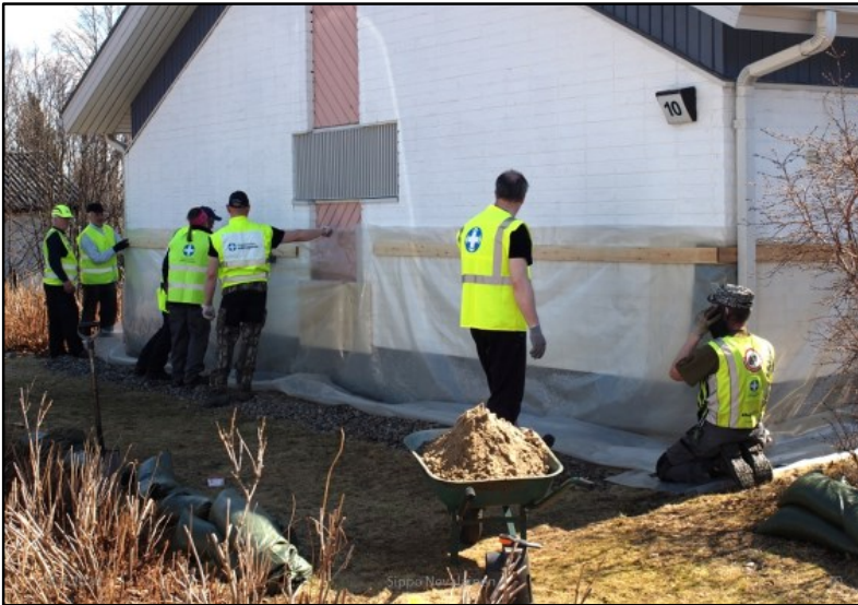
Kuva 41. Vapaaehtoisia auttamassa tulvasuojausten tekemisessä kevään 2020 tulvassa Rovaniemellä (kuva: Sippo Nevalainen/VAPEPA).
