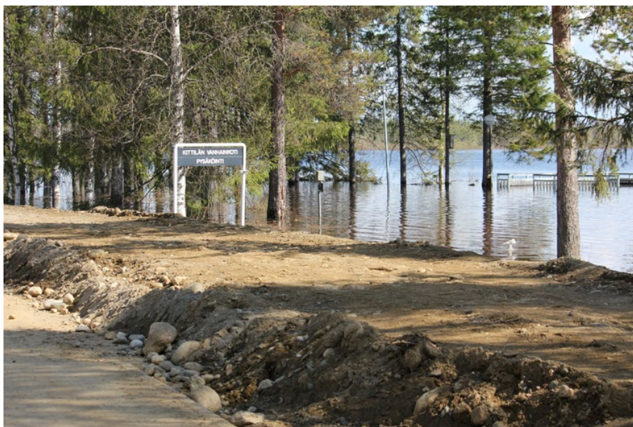
Kuva 37. Tilapäinen tulvapenger Pääskyläniemen palvelutalon suojana keväällä 2018 (kuva: Lapin ELY-keskus).
