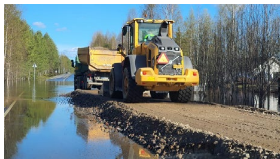
Kuva 40. Tien tilapäinen korottaminen maa-aineksella (Kuva Lapin ELY-keskus).
