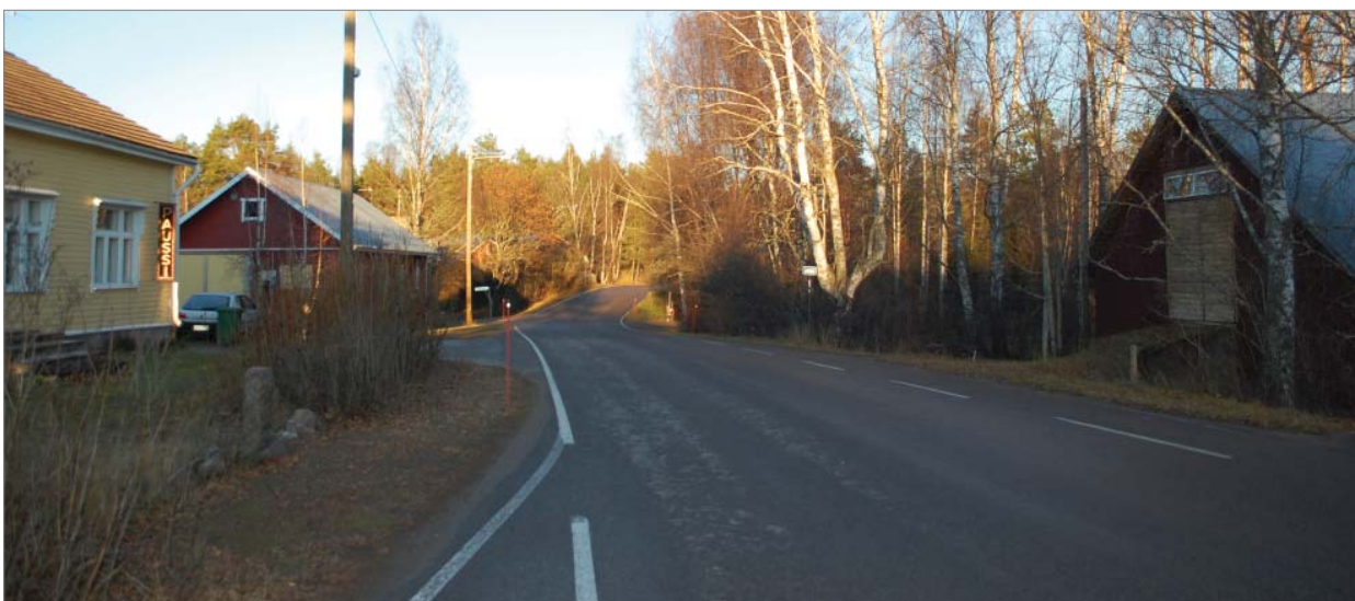
Kylän rakennuskantaa ja opastaulu. Pihojen kasvillisuus ulottuu paikoin hyvin lähelle tietä ja saattaa haitata näkemiä.LS
