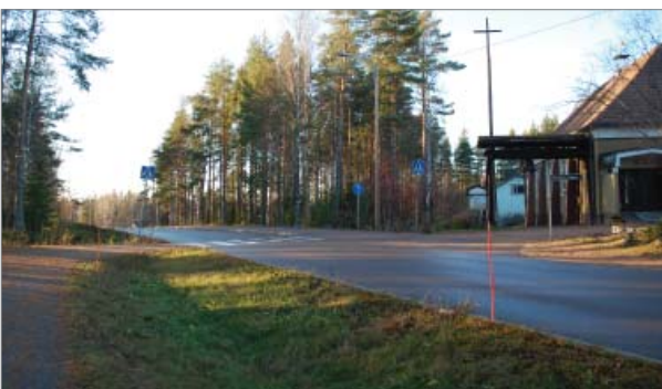
Tien laki sijoittuu kylälle saavuttaessa juuri ennen kirkon ja koulun liittymän kohtaa. LS
