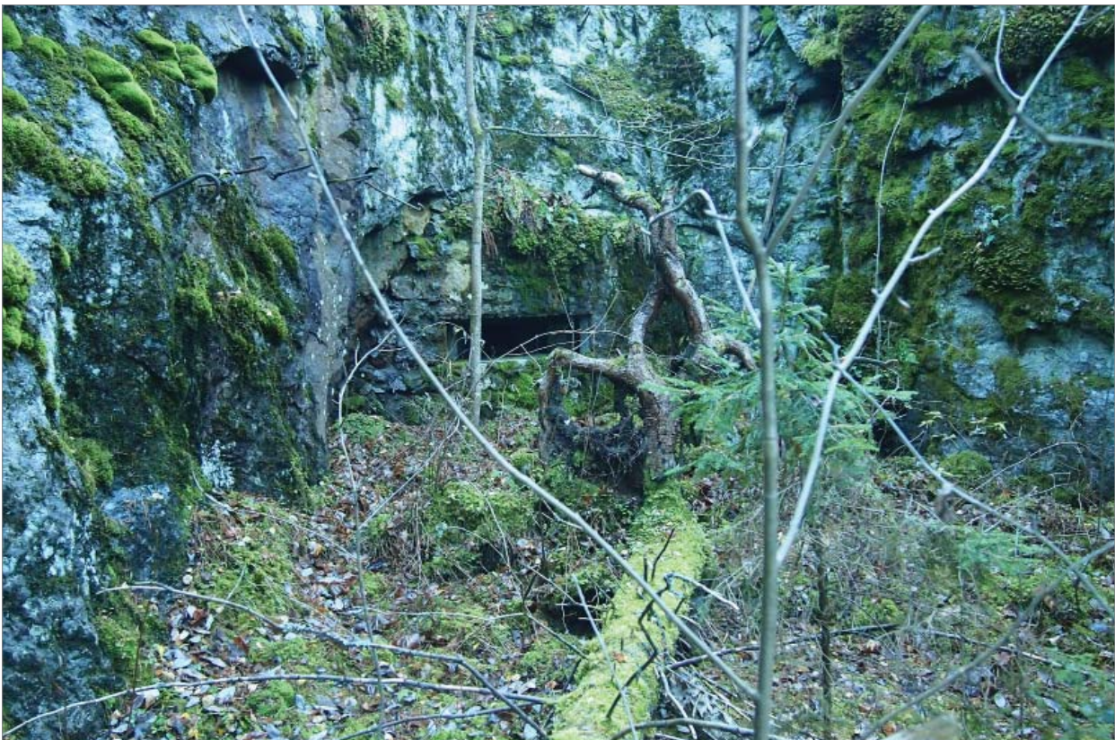
Salpalinjan kantalinnoitteet on maastoutettu Ravijoen kallioihin. Luonto on parantanut naamiointia. Konekiväärikorsun ampumaukko on vain muutaman metrin päässä tiestä. Näiden rakenteiden ja laitteiden sotilaallinen arvo on nykyisin olematon. Niitä voitaisiin nostaa näkyviin nykyistä enemmän kulttuurimuistomerkeinä. MP
