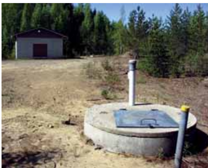
Pohjavedenottamot on usein perustettu vanhoihin sorakuoppiin. Rääkkylä, Leppälammen vedenottamo. Kuva Ari Lyytikäinen.
